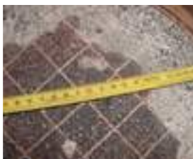
Odkładanie się zanieczyszczeń w powierzchni wlotowej → uszkodzenie wlotu powietrza filtra? Formowanie związków siarki?
